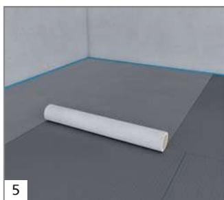
5 Appliquer sur toute la surface la large bande d'armature autocollante wedi *Tools* avec un recouvrement d'env. 5 cm. Dans les zones humides, pourvoir les percements et les jonctions entre les panneaux de construction de la bande d'étanchéité wedi *Tools*.
