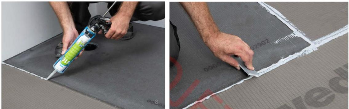
**Fig 19 : joints entre panneaux et entre panneaux et receveur wedi Fundo avec wedi 610**
